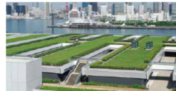
屋上緑化広場
